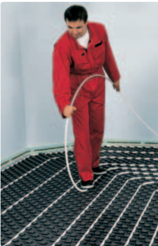
De Uponor Tecto elementen kunnen heel eenvoudig alleen worden gemonteerd. Net als de flexibele Uponor Wirsbo PE-Xa leidingen: met de voet erin drukken - klaar
