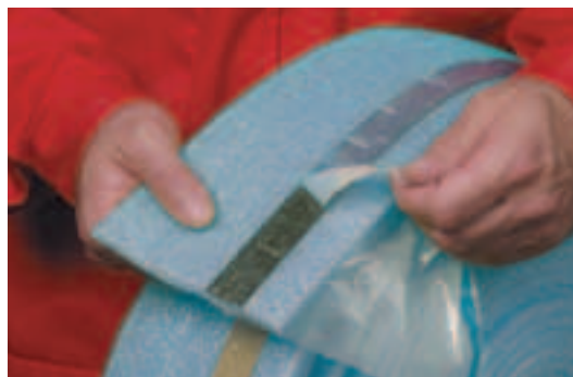
Configuratie van de randisolatiestroken bij de variant met uitvlakelement
