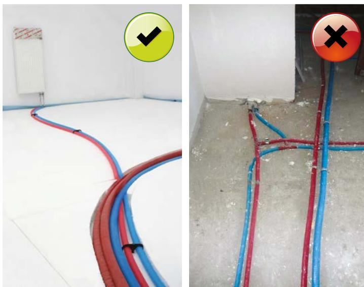
Чтобы исключить чрезмерную нагрузку на фитинги вследствие воздействия сил, возникающих при сгибании трубы, не рекомендуется сгибать трубу ближе, чем 10 наружных диаметров от фитинга.
