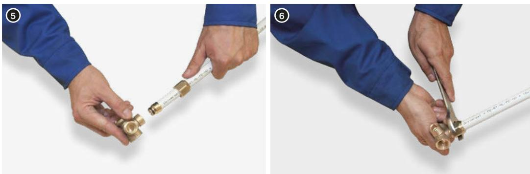
6. Гайку конусного соединителя (соединителя для многослойных труб) накрутить на фитинг с помощью рожкового ключа.
