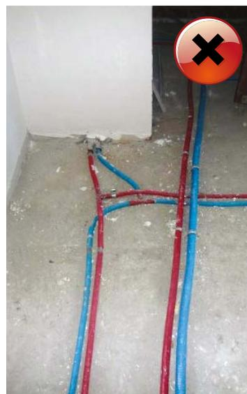
Чтобы исключить чрезмерную нагрузку на фитинги вследствие воздействия сил, возникающих при сгибании трубы, запрещается сгибать трубу на расстоянии меньшим, чем 10 наружных диаметров от фитинга.
