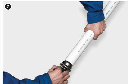
3. Правильно раскалиброванный конец трубы насадить на фитинг. Через контрольные отверстия в стальном кольце следует проконтролировать правильность вставки трубы - труба должна быть видна в отверстиях.
