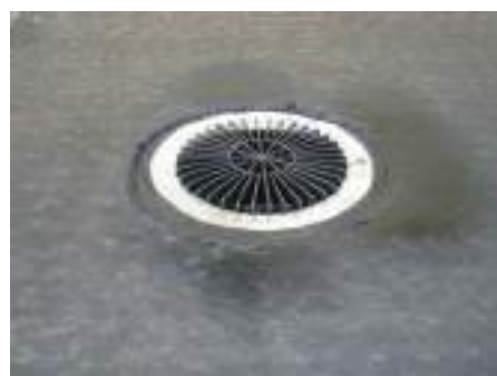
5. A szakszerűen beépített lefolyó kétrétegű bitumenlemez szigeteléssel
