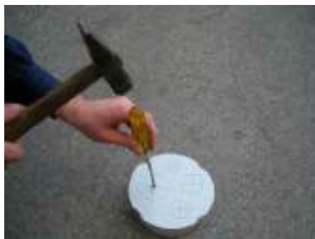
2. В монтажном элементе подготовить отверстия нужного диаметра
