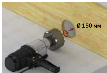
1. Пробурить отверстие Ø 150 мм или проделать отверстие 150 x 150 мм
