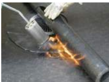
4. A második bitumenlemez réteget is a gallérhoz kötjük
