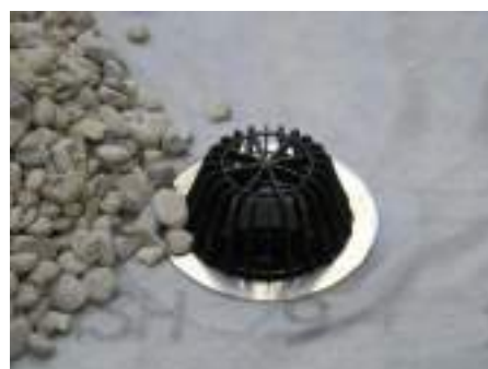
11. A lombfogó kosarat bepattintjuk és a környékét 16/32 mm méretű kavicsal fedjük
