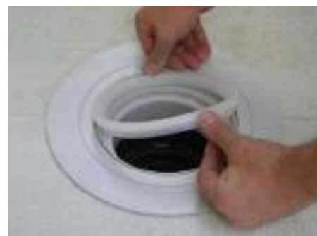
9. Az átlátszó tömítőgyűrűt a szigetelő karima hornyába helyezzük
