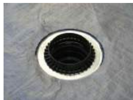
6. Levesszük a védőfedelelet, lefektetjük az elválasztó réteget és behelyezzük a vízátvezető gyűrűt
