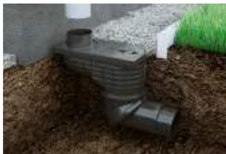
1. Установите дождеприёмник
