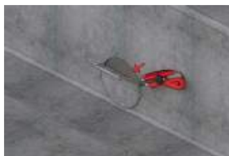
4. Вырезать отверстие в битумной гидроизоляции в месте установки парапетной воронки
