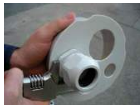
3. Установить и зафиксировать кабельные вводы.
