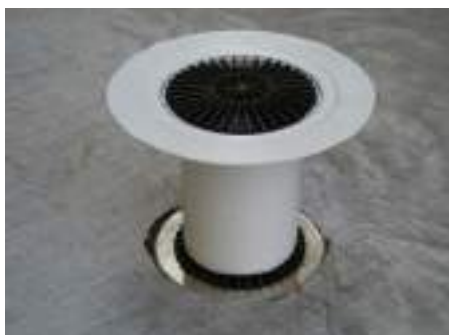
7. A méretre vágott HL350.0 szigetelőkarimás magasító elemet a vízátvezető gyűrűre húzzuk
