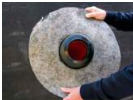
2. Надеть гидроизоляционную мембрану
