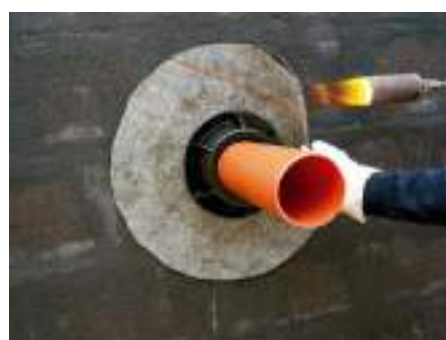
5. Приварить мембрану к битумному покрытию стены
