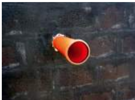
1. Труба проведена через стену с битумным покрытием.
