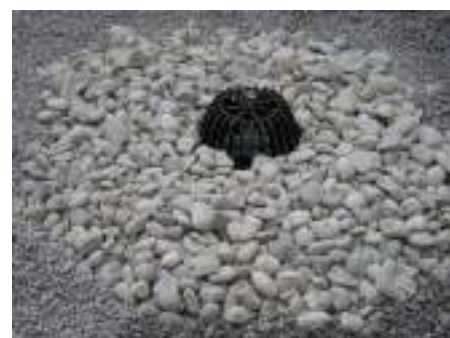
12. Kavicsfedést elvégezzük
