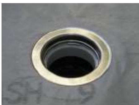
10. A szűrőfátyolt a nemesacél szorítótárcsával rögzítjük
