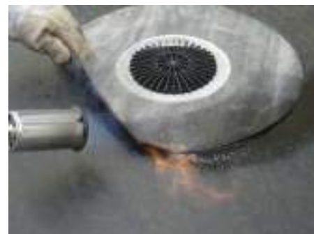
3. Az első bitumenréteget a födémhez olvasztjuk, majd a lefolyó bitumen szigetelőgallérját erre a rétegre melegítjük.
