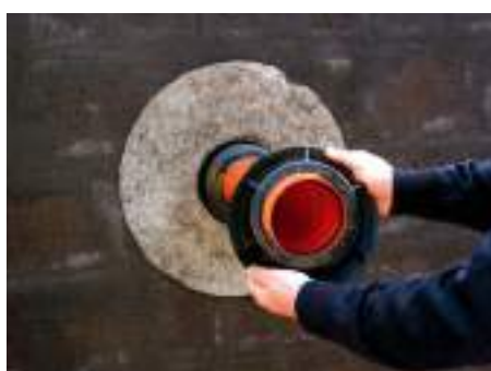
4. Установить фиксирующую гайку
