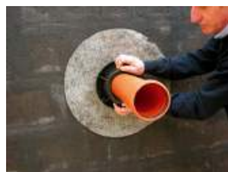
6. Затянуть фиксирующую гайку
