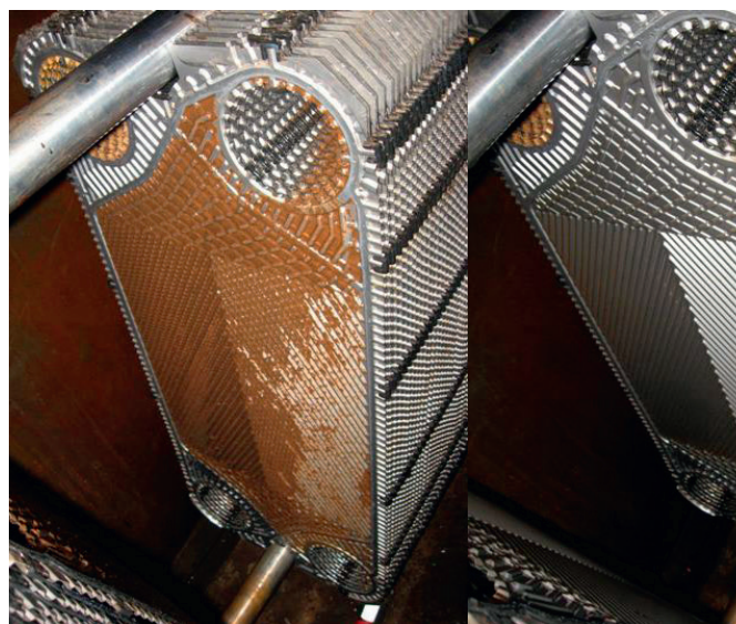
Пластинчатый теплообменник, забитый отложениями шлама
